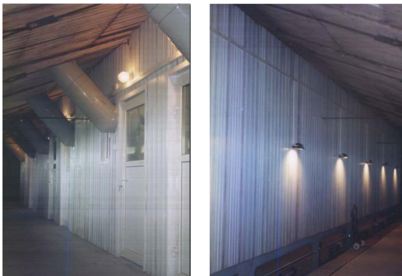
Foto. 1. Front i tył komór mikroklimatycznych. Widoczne przewody zasilające oraz szuflady gnojowe Fig. 1. Back and front of climatic chambers, with visible feeder cables and dung trays
