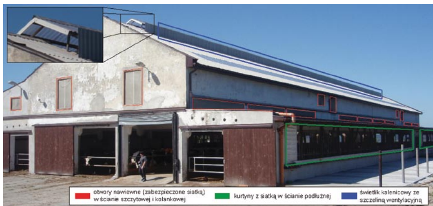
Fot. 2. Widok obory od strony północno-wschodniej z zaznaczonymi elementami systemu wentylacyjnego (źródło własne)
