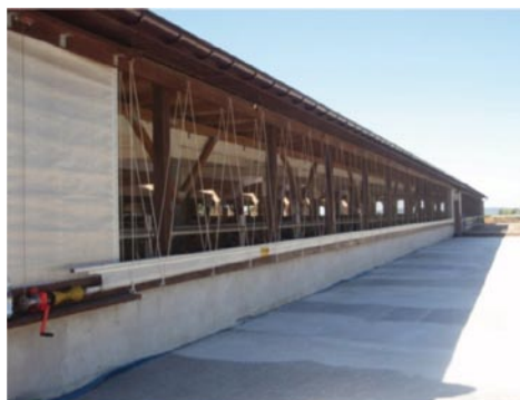
Fot. 3. Ściana północna obory z opuszczonymi kurtynami (źródło własne)
